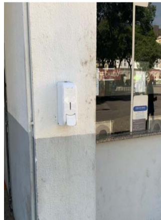
Figura 2.7 – Estação Praça XV/Dispenser com álcool em gel na bilheteria
