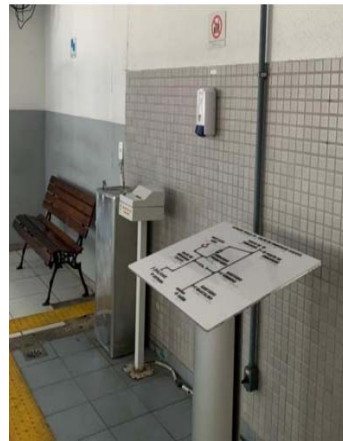
Figura 2.10 – Estação Cocotá/Dispenser com álcool em gel no salão de espera
